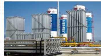
LNG re-gasification station
